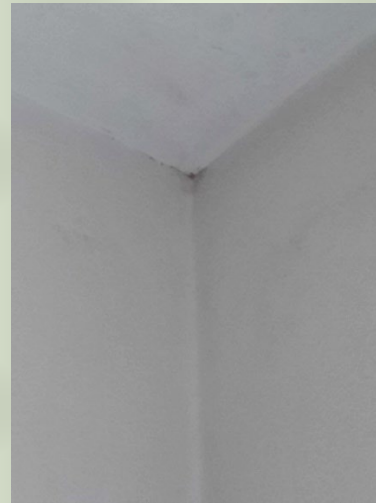
Abbildung 2: Verschimmelte Wandecke
