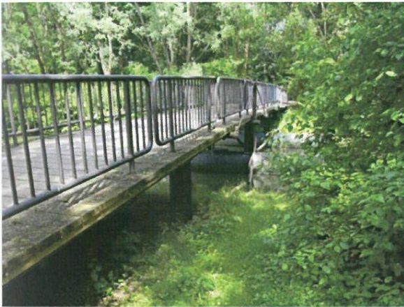
Abb. 1 Fußgänger- und Radwegbrücke in der Rheinaue Quelle: eigenes Foto
