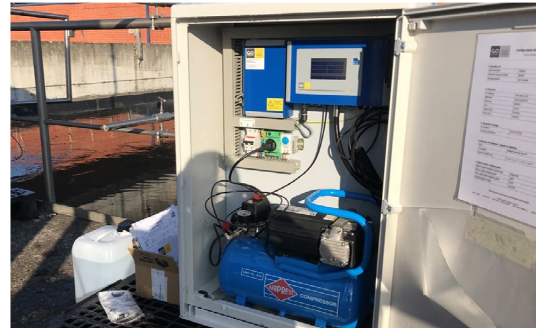
Installation der neu beschafften Messtechnik am Klärwerk Herrenhausen in Hannover / © Stadtentwässerung Hannover
