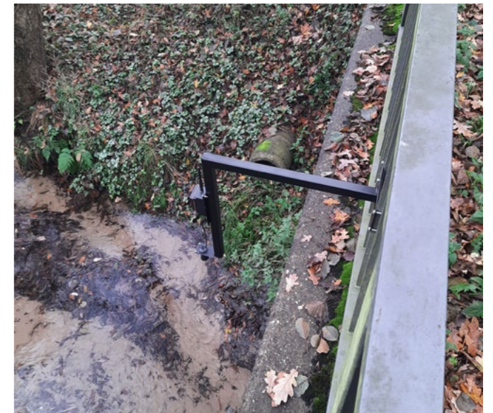
Low-Cost Sensor mit direkter Übertragung zur Messung des Wasserstands an einem Gewässer im Untersuchungsgebiet in der Nähe einer Probestelle / © Nicolai Bätz, Lippeverband, 2023
