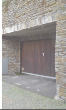
Bruchsteinmauer
