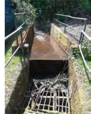
Abbildung 80 Boppard: Einmündung des Bruder-Michels-Bachs in den Rhein. Betonierete Sohle, erschwerter Zugang. (Quelle: Hochschule Koblenz/Kimmel 2020), Fraubach, maroder Rechen vor verrohrtem Abschnitt (Quelle: Hochschule Koblenz/Kaspar 2020)
