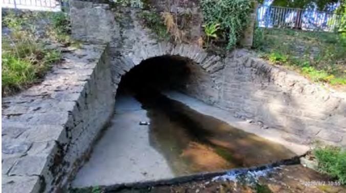
Abbildung 80 Boppard: Einmündung des Bruder-Michels-Bachs in den Rhein. Betonierete Sohle, erschwerter Zugang. (Quelle: Hochschule Koblenz/Kimmel 2020), Fraubach, maroder Rechen vor verrohrtem Abschnitt (Quelle: Hochschule Koblenz/Kaspar 2020)
