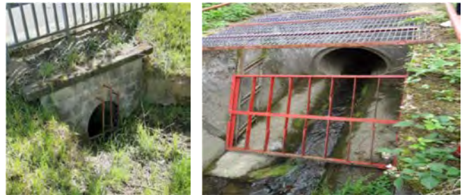
Abbildung 123 St. Goar: Lohbach, Bestehender Einlauf in die Verrohrung; Vorschlag des Einbaus eines Rechens (Hochschule Koblenz/ Gelhard, 2020)
