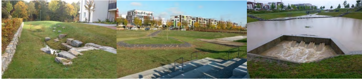
Abbildung 48: Wasserführende Gräben (links, Quelle: Matzinger et al., 2017, Foto: Dreiseitl) und tiefergelegte Freiflächen zum Wasserrückhalt (Mitte, rechts): Frankfurt Riedberg, rechts nach starkem Regen (Fotos: Hochschule Koblenz/Ziegler 2018, Stadtentwässerung Frankfurt am Main, 2016)
