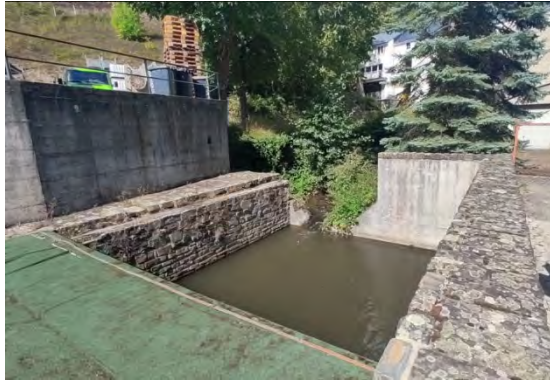
Abbildung 91 St. Goarshausen, Hasenbach: Einlauf in eine Verrohrung, Weingut Leonhardt, Kellerei Loreley; Auslauf des Hasenbachs aus Verrohrung, kein Zugang, vermauerte Ufer (Quelle: Hochschule Koblenz/Kimmel 2020)
